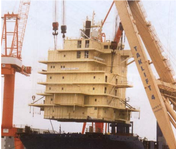
Bild 2.1.2-2: Aufsetzen eines Deckshauses
