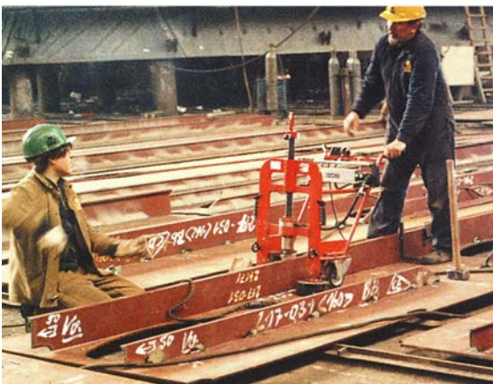
Bild: Vorrichtung zum Anpressen von Profilen an die Platte (Magnet und Spindel)
