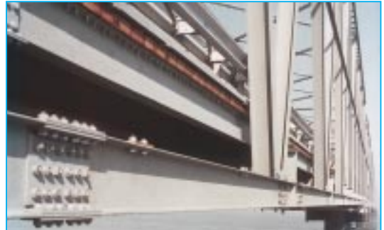
1 Schraubverbindung an einer transportablen Brücke
